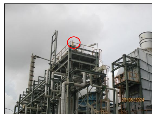
รูปที่ 3-43 Pressure Relief Valve
