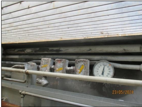
รูปที่ 3-44 ระบบ High Temperature Monitoring
