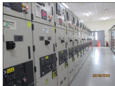
รูปที่ 3-19 ระบบ Remote Isolation
