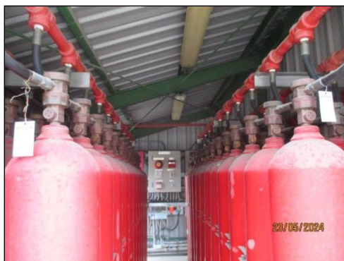
รูปที่ 3-40 Extinguisher Discharge System
