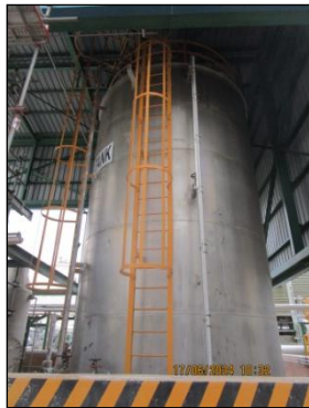
รูปที่ 3-30 ถังเก็บสารละลาย แอมโมเนียมไฮดรอกไซด์
