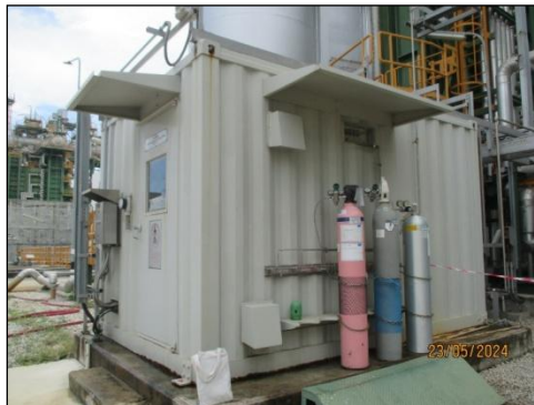
รูปที่ 3-1 ระบบการติดตามตรวจสอบคุณภาพอากาศจากปล่องระบายอากาศแบบต่อเนื่อง (CEMS)
