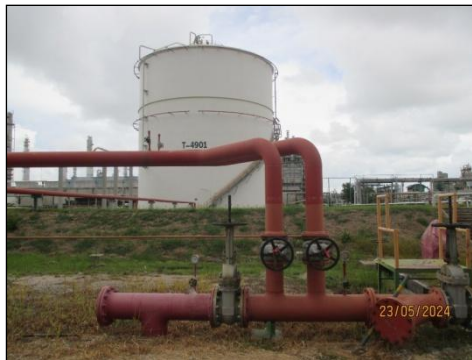
รูปที่ 3-23 ระบบเชื่อมต่อระดับเพลิงของหน่วยผลิตไฟฟ้า EPS และโรงผลิตสารโอเลฟินส์ สาขานนไเอ-หนึ่ง
