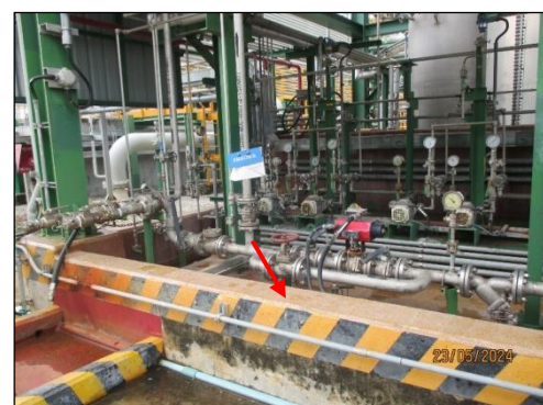
รูปที่ 3-7 เขื่อน (Bund) ล้อมรอบ บริเวณพื้นที่เก็บและสูบถ่ายสารเคมี
