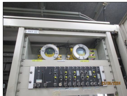
ระบบ Gas Detection บริเวณ Generator Cabinet
