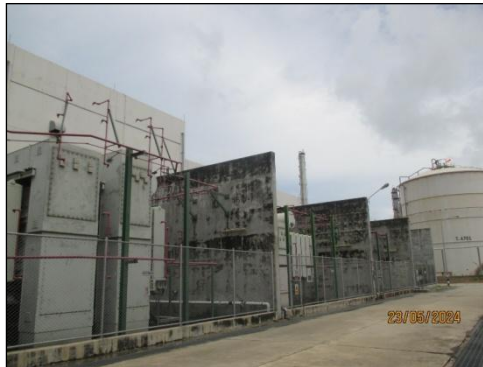
รูปที่ 3-21 พ่นกันไฟระหว่างหม้อแปลงไฟฟ้าแต่ละชุด
