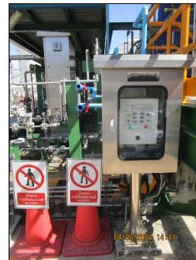
รูปที่ 3-33 เครื่องตรวจวัดการรั่วไหล (Ammonia Detector)
