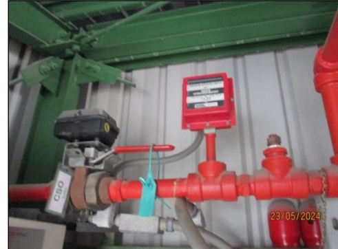
รูปที่ 3-39 Solenoid Valve CO 2
